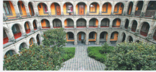
Figura 2.58. Interior del Antigua Colegio de San Ildefonso.
